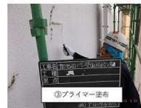
壁面防水塗装施工工事
